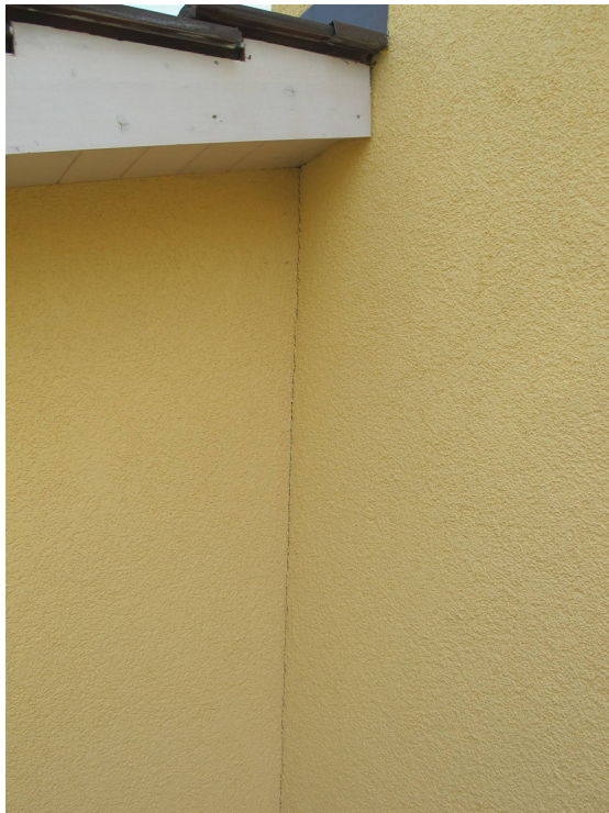
Foto 11: IMG_0018.JPG / Aussen Fassade / Nord
