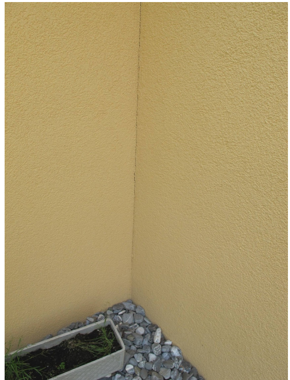
Foto 12: IMG_0019.JPG / Aussen Fassade / Nord
